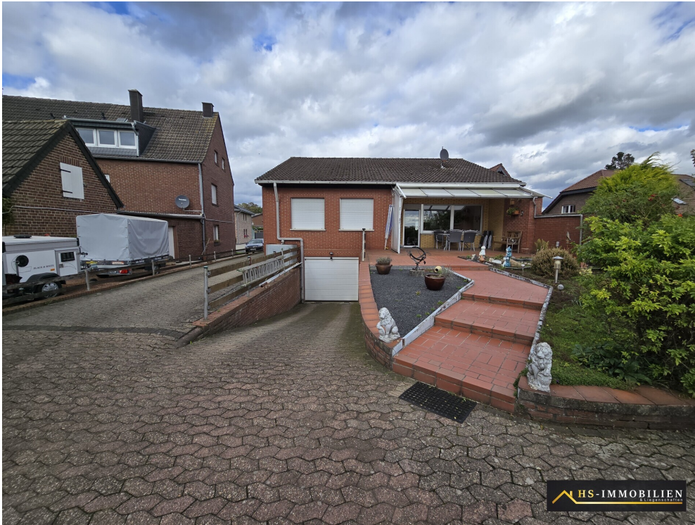
Ansicht hinten Garage+Terrasse
