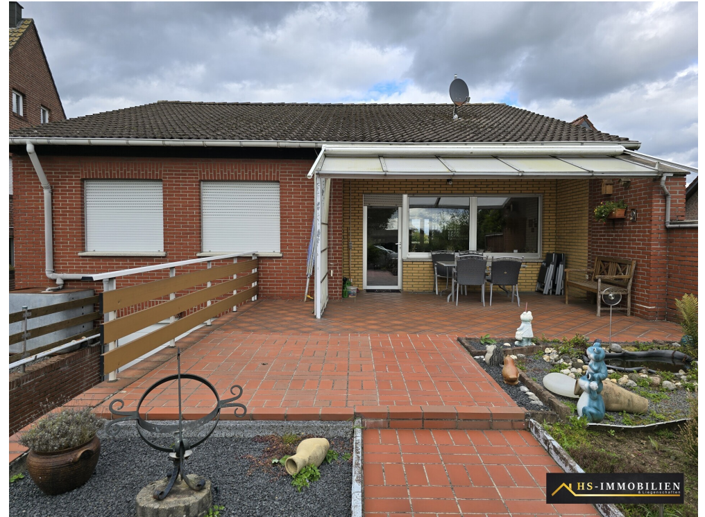
Ansicht hinten Terrasse
