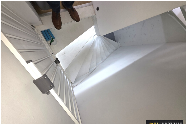
EG Treppe zum Keller
